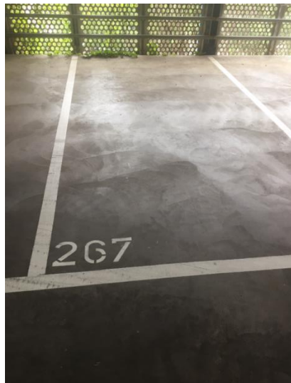
Εικόνα 4 Ελεύθερη θέση στάθμευσης για εγκατάσταση αισθητήρα
