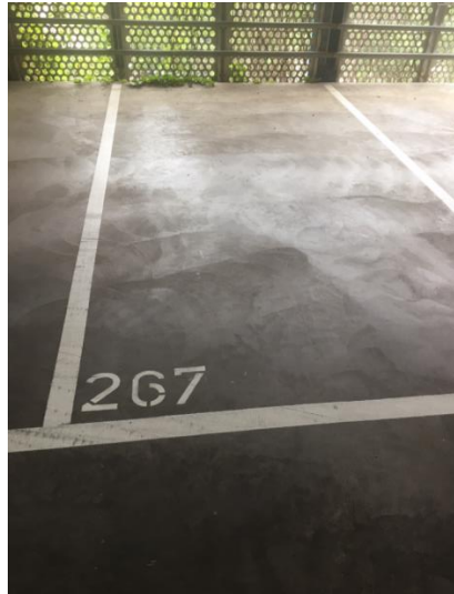
Rys. 4 Wolne miejsce parkingowe przygotowane do montażu czujnika
